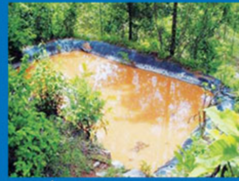
सिँचाई पोखरीको निर्माण
